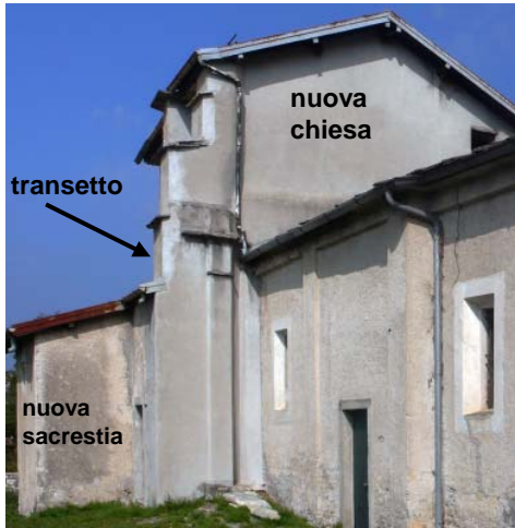
Lato Sud dell'oratorio
