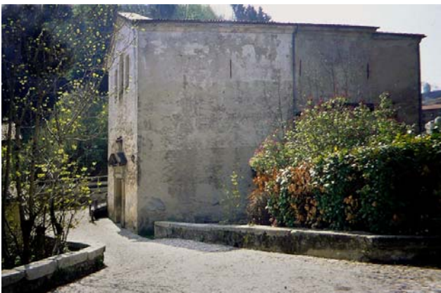
Il ponte di Garelo presso l'ex oratorio, lungo la strada antica
