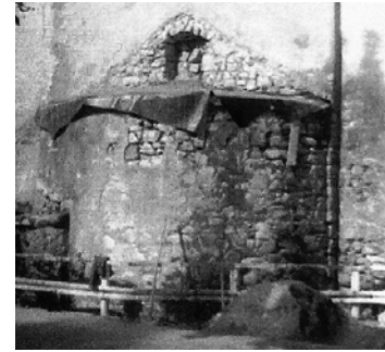
L'abside antica prima del restauro
