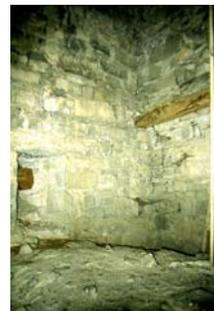
Interno della zona intermedia. A sinistra si vede l'estremità del travone del tetto della navata alloggiato in una precedente finestrella a feritoia, rimaneggiata quando la navata fu innalzata e involtata (intorno al 1588). In basso si vede l'estradosso della volta che copre la tribuna
