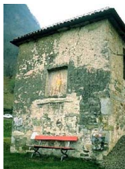
S.Vitale. Facciata “romanica”, ora parete di fondo.
