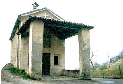
S.Vitale. Attuale facciata con atrio
